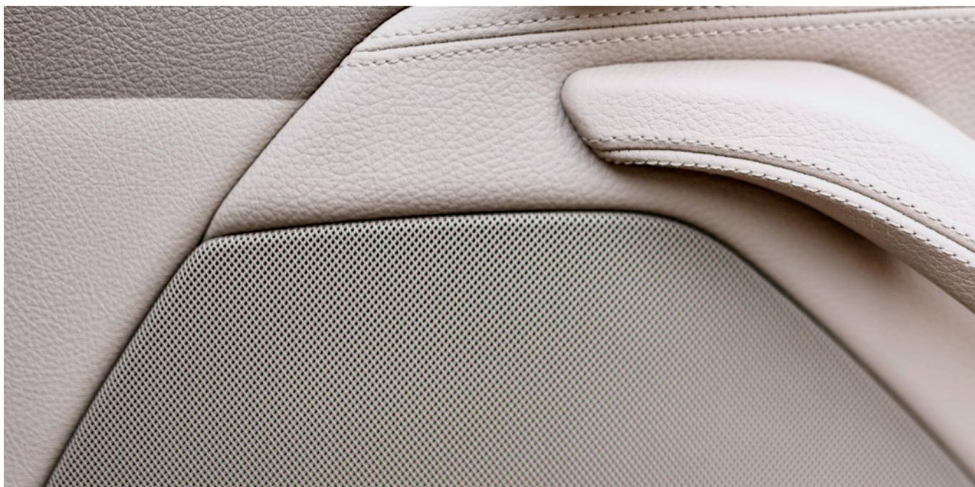
Oberflächenverdichtete Polyurethan-Polyether-Schaumstoffe werden als Kaschierschäume für belederte Interieurteile eingesetzt. Mittels unseres Fertigungsverfahrens wird die Schaumoberfläche geglättet. Damit wird die bei der Klebekaschierung typische Orangenhautbildung vermieden und dem fertigen Bauteil eine hochwertige Oberflächenbeschaffenheit verliehen.
